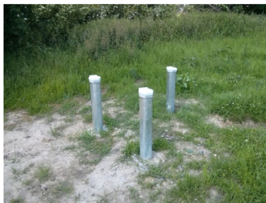
Überwachung des Neubaus von Grundwassermessstellen
