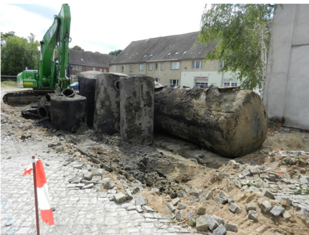
Tankbergung im Bereich der ehem. Tankstelle
