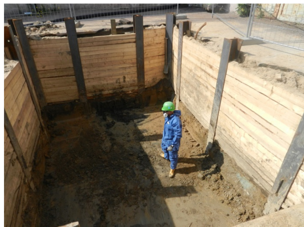
Baugrube 2 im Bereich des Altöltanks
