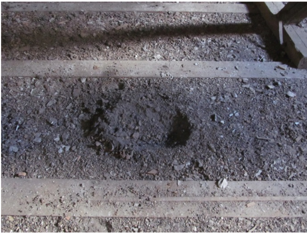
Probenahme für Deklarationsuntersuchungen der schlackehaltigen Fußbodenschüttung
