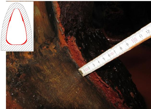
**Erfassung der Ablagerungsmächtigkeiten im Kanalquerschnitt und der Ablösbarkeit der Schlämme und Krusten**
