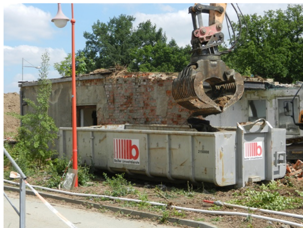
Überwachung des Rückbaus. Hier: Separierung der teerhaltigen Baustoffe des Dachaufbaus
