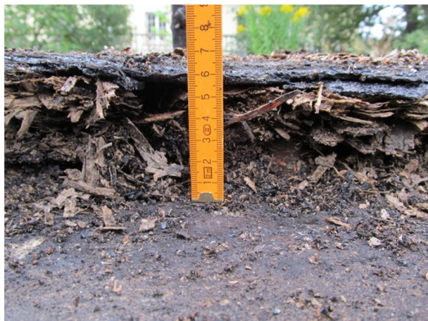
Erfassung des Dachaufbaus und Untersuchung der Bestandteile auf gefährliche Stoffe
