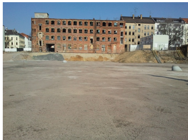
Vordergrund: Planum der SZ 3 nach Abschluss der Sanierung Hintergrund: Gebäude 67/69; Kernbereich der SZ 3.3 Boden- und Gebäudesanierung (Sanierungsplanung)
