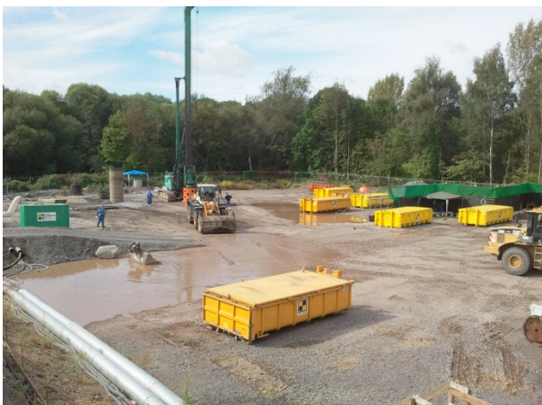
öBÜ Großlochbohrungen in Sanierungszone SZ 3
