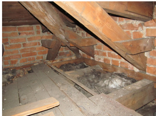
Mineralfaserdämmung im Fußboden des Dachgeschosses
