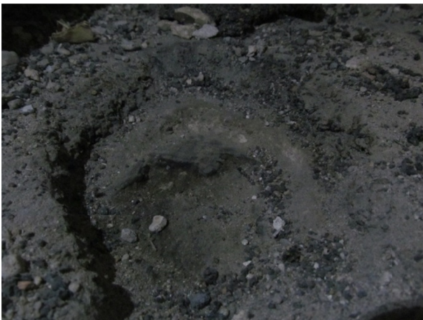
Teerkork und Schlackeschüttung als Fußbodenisolation
