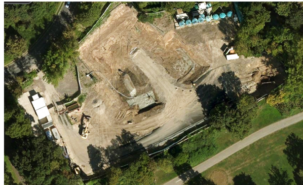
Zustand des Geländes zum Zeitpunkt der Sanierung
