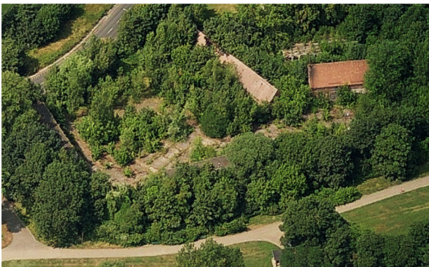
Zustand des Geländes zu Beginn des Monitorings
