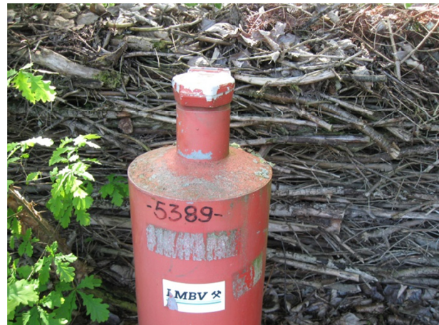
Grundwassermessstelle der LMBV mit Identifikationsnummer
