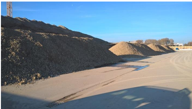
Beprobung der aufgehaldeten Inputfraktionen für den Testbetrieb der PFC-Bodenwäsche
