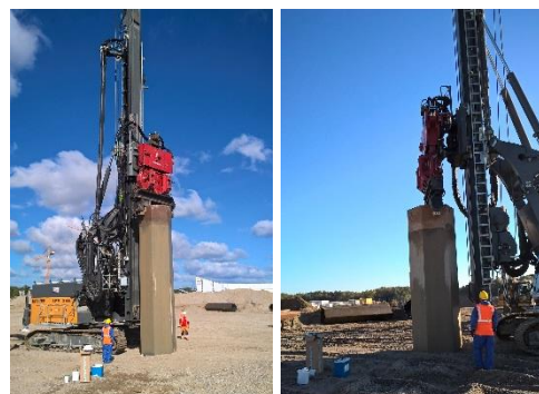
Teufendifferenzierte Beprobung des Wabenaushubes während der ergänzenden Untersuchungen der MKW-Schadensbereiche
