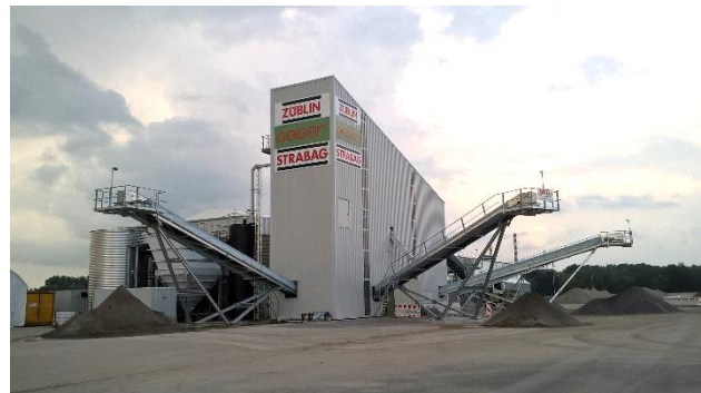
Bodenwaschanlage: Beprobung der Outputfraktionen (Boden) zur Kontrolle und Überwachung des Reinigungserfolges sowie des Prozesswasser zur Überwachung Bilanzierung der Schadstoffströme
